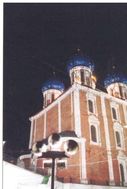
Рис. 2. Опора с прожекторами у восточного и северного фасада
