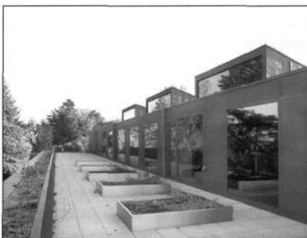
Рис. 2. Северо-восточный фасад. Большие светопроемы в крыше для освещения абонементных зон второго этажа
