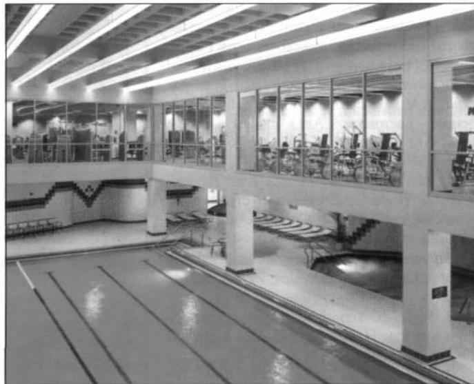
Рис. 26. Освещение бассейна световодами фирмы TIR (длина 32 м, вводное устройство для МГЛ 400 Вт с каждой стороны)
